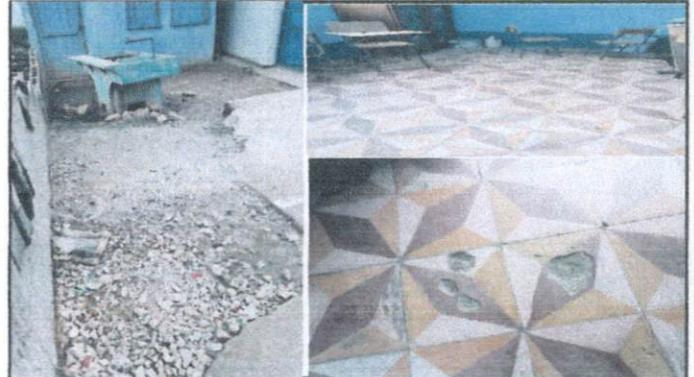
Foto 2: Sustitución de piso de cemento liquido Y Sustitución de piso de granito
